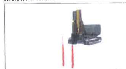
3. Perforazione e riempimento della seconda fondazione
