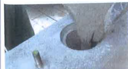
Colare la malta per Iniezione nelle fondazioni
