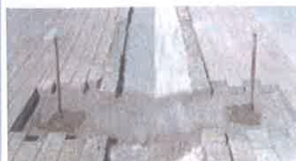
Pali di Iniezione Installati prontamente
