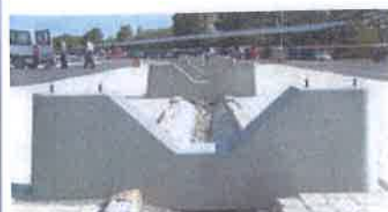
Fondazione prefabbricata inserita e livellata
