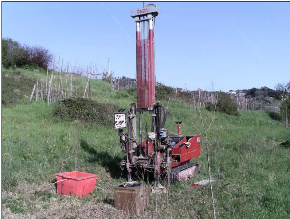
Postazione della prova penetrometrica CPT 1
