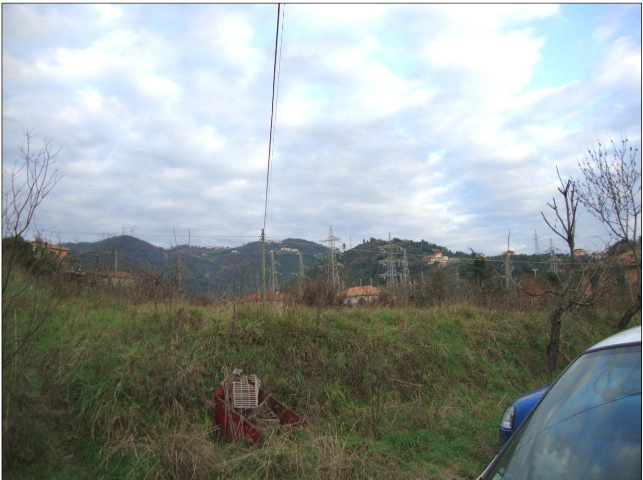
L'abbandono delle colture agricole e la presenza di tralicci ed impianti nell'immediato intorno
