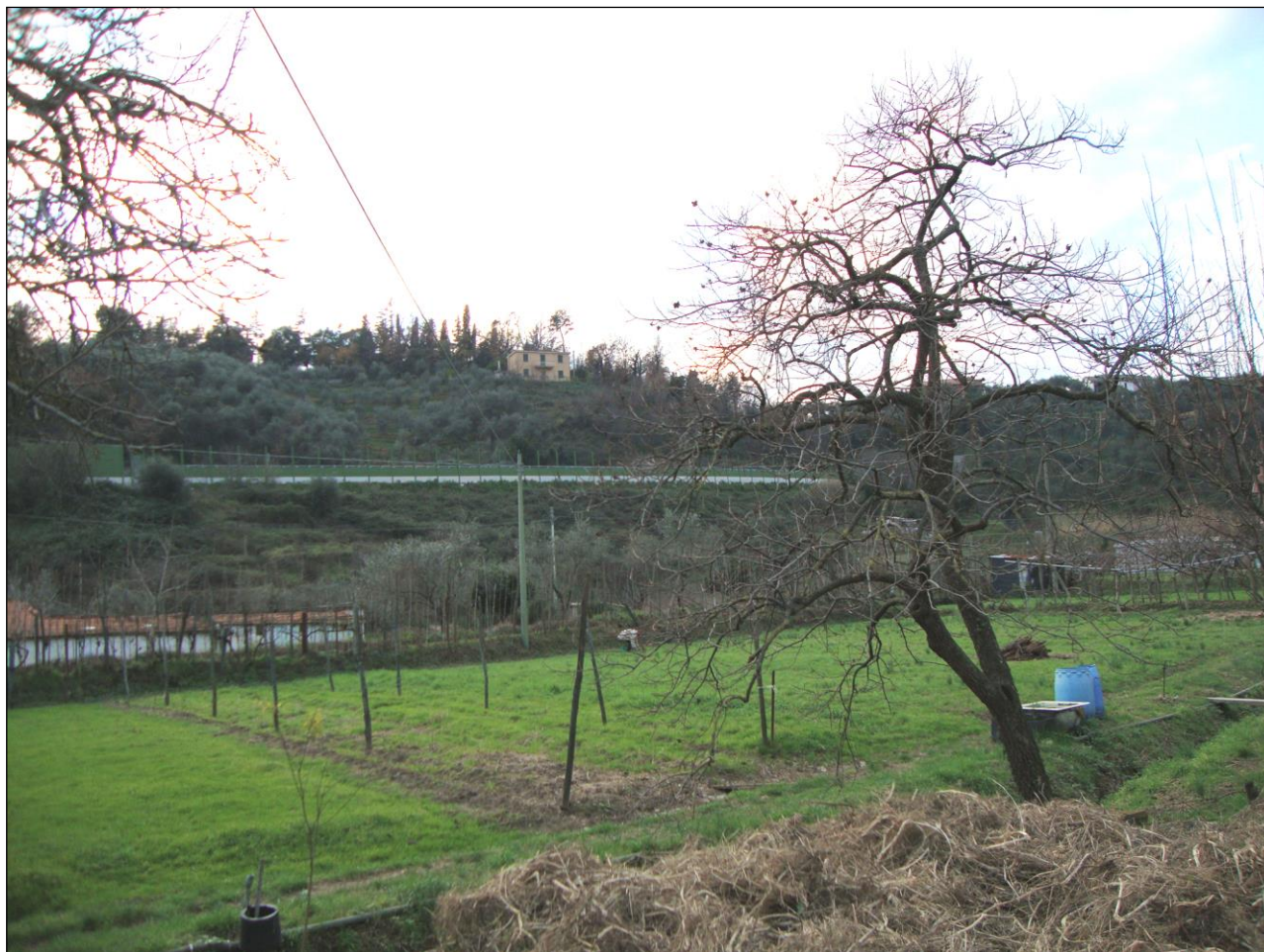
Veduta del tratto autostradale ripreso dal sito dell'intervento
